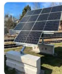
Les rails de profilage ne sont pas utilisés sur les suiveurs DEGER
