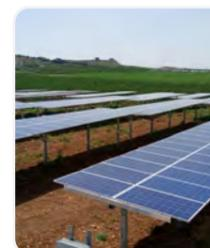
Limite de vitesse du vent réglable pour chaque système de suivi solaire (maximum 12 m/s).
